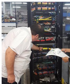
Vérification des câblages et des schémas
